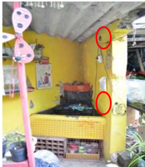
Foto: Abajo, detalle falsa llave de paso de agua. Arriba orificio a través del cual se inyecta aire para hacer funcionar el motor neumático que hacía elevar la plataforma.
