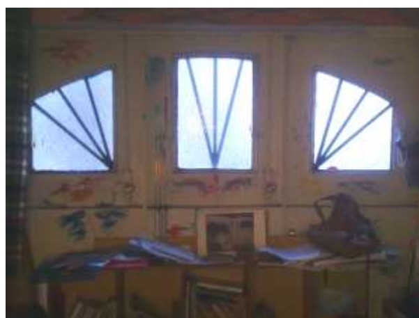
Foto: Se identifica en portón blindado que da a la calle, marcas de metrallera A3 coloreadas.
