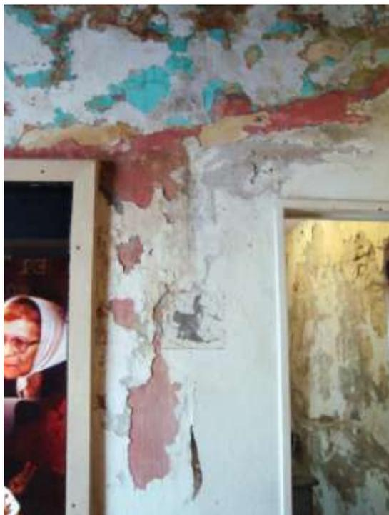
Figura 5 – Paredes raspadas apresentam as diversas pinturas
