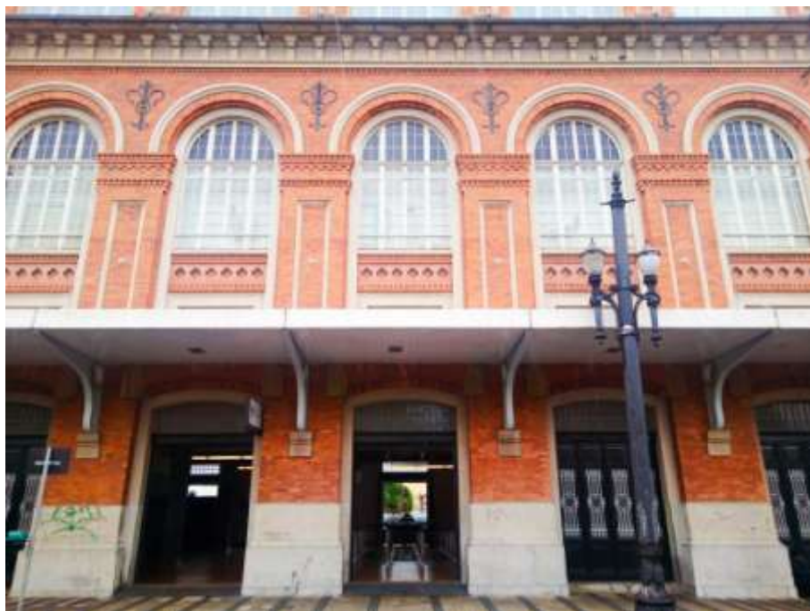
Figura 7 - Foto da entrada do Memorial da Resistência (Foto: Do autor, 2017. Acervo pessoal).
