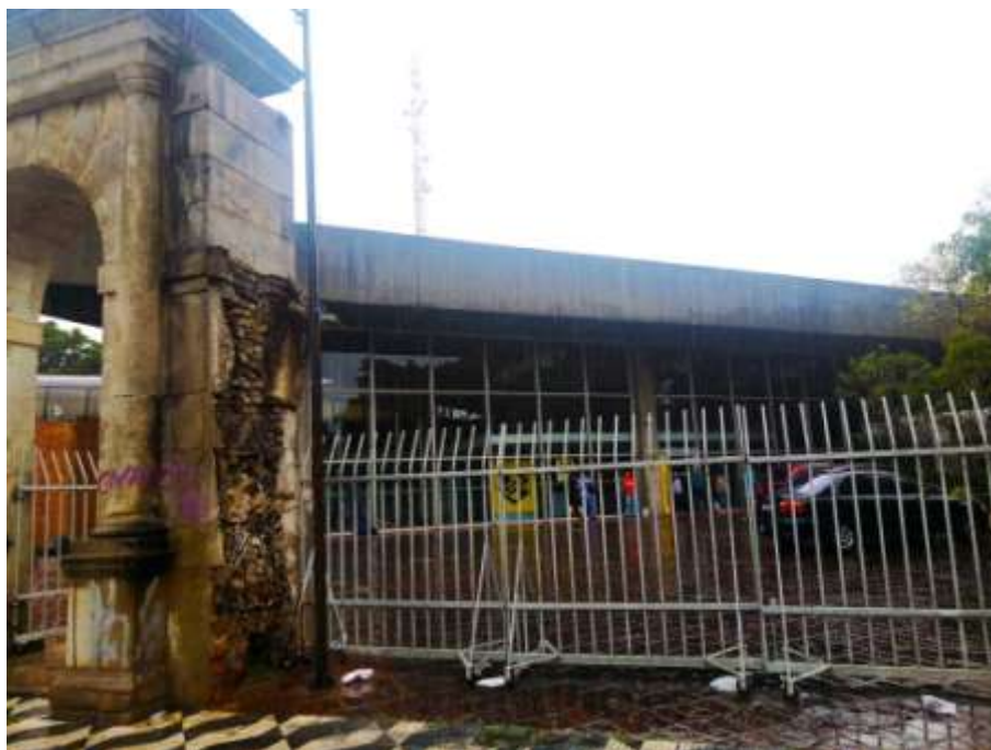
Figura 4 - Foto da entrada de pedra, em que se vê atrás dele e das grades que o ladeiam, a agência do Banco do Brasil (antiga agência da "Nossa Caixa, Nosso Banco") e seu estacionamento. Sem qualquer menção à história do local (Foto: Do autor, 2017. Acervo pessoal)
