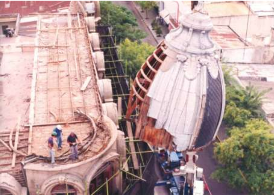
Tareas de desmonte de la cúpula previa a la demolición de la casona. Febrero/marzo 1998. (Archivo Zingoni).
