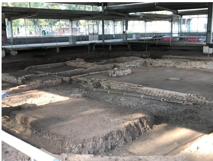
Fotografía N°2, detalle de los cimientos. Fuente, fotografía tomada durante trabajo de campo el 12 de junio de 2019.
